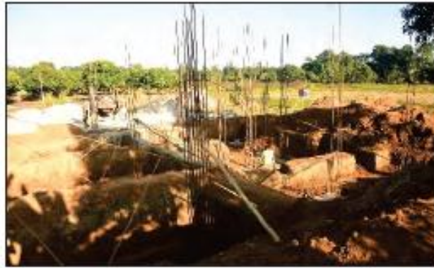
आरआरसीसी फार्म हाऊस भवन का निर्माण प्रगति पर ।
